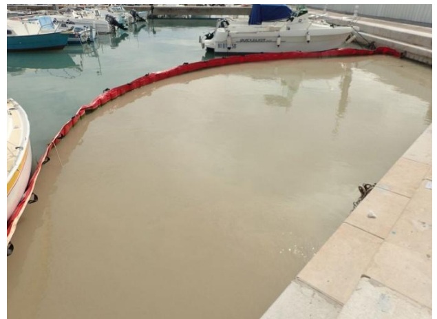
Evacuation dans le port des rejets du chantier
