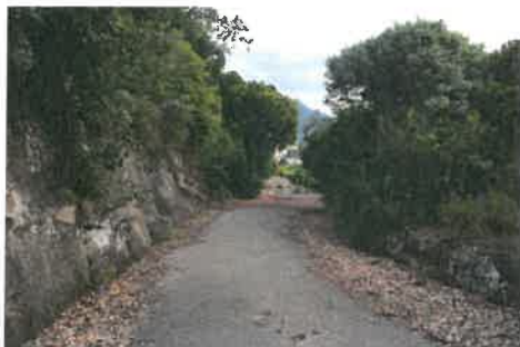
Route taillée dans le grès de Menton au sommet de la colline
