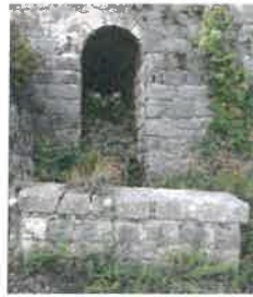
Voûte de transit 7
