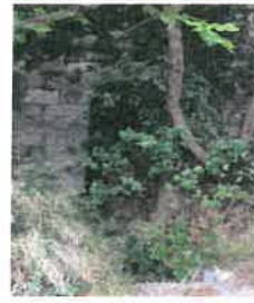
Voûte de transit 8
