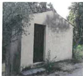
Bât gestion eaux
