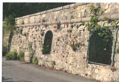
Vue d'ensemble des trois ouvrages
