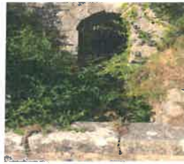
Voûte de transit 5
