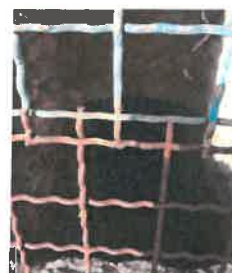
Voûte de transit 3
