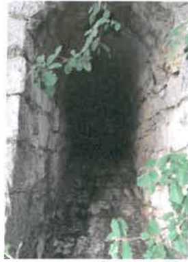
Voûte de transit 10
