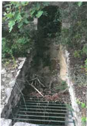
Voûte de transit 11
