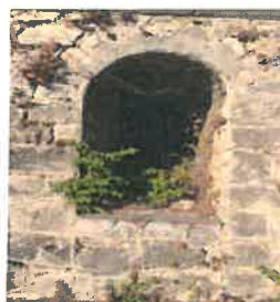
Voûte de transit 2
