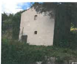
Bâtiment de gestion des eaux
