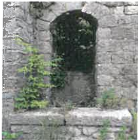
Voûte de transit 6
