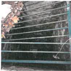
Canal d'évacuation le long de l'escalier à hauteur du lacet 9
