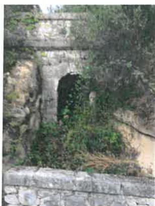
Voûte de transit 13
