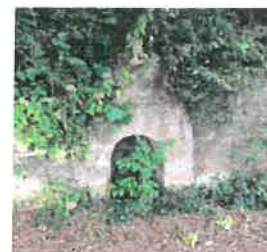
Voûte de transit 4
