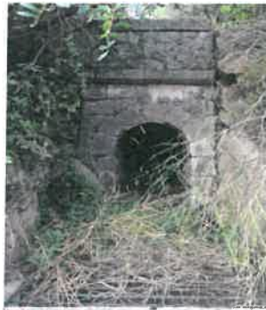
Voûte de transit 12
