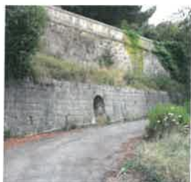
Voûte de transit 1
