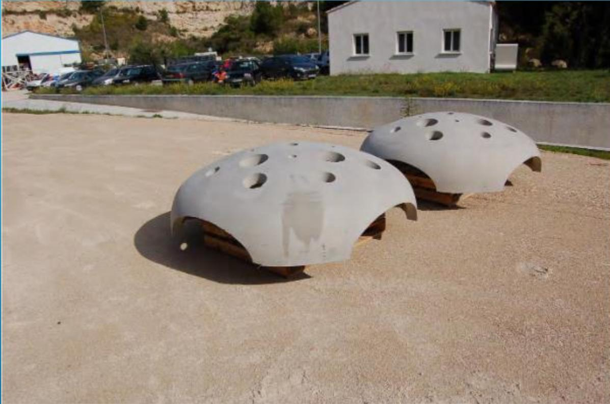
Modules imitant les cavités naturelles à placer sur les enrochements de la digue récifale sous-marine
